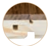
Nut- und Federverbindung
